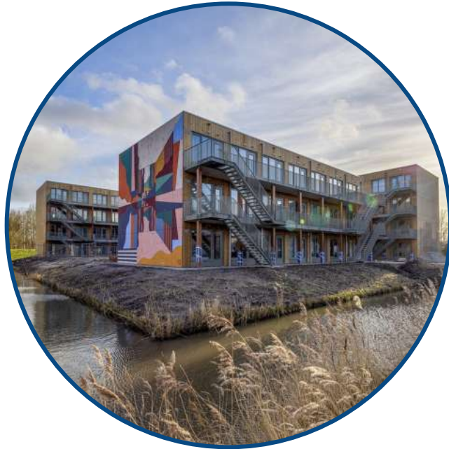
Oplevering van de complete installatie met garantie en nazorg
